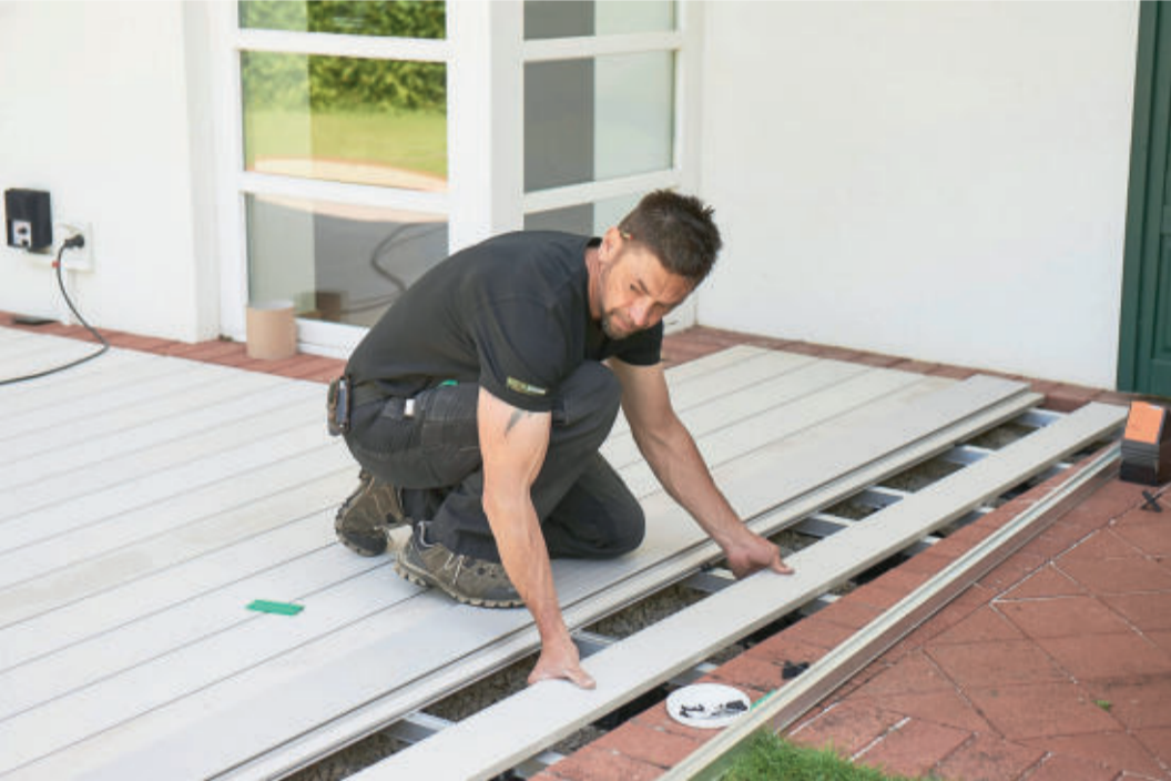
Zuerst ein Schotterbett, dann eine Unterkonstruktion, zum Schluss die WPC-Dielen: So baut man eine Terrasse fachgerecht auf. Foto: djd/NATURinFORM
